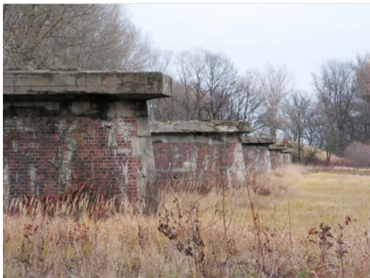
Rys. 5. Zachowane filary mostu odrzańskiego w Bytomiu.
