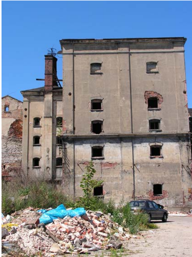
Ryc. 4. Elewacja wschodnia, pomieszczenia suszarni. Stan obecny. Fot. M. Danowska.
