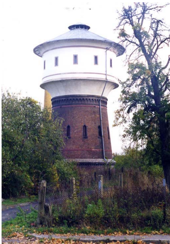
Fot. 11. Kolejowa wieża ciśnienia w Lubsku.
