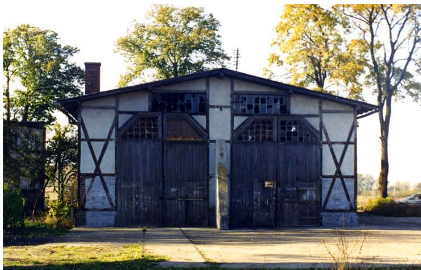
Fot. 3. Lokomotywnia w Krośnie Odrzańskim.
