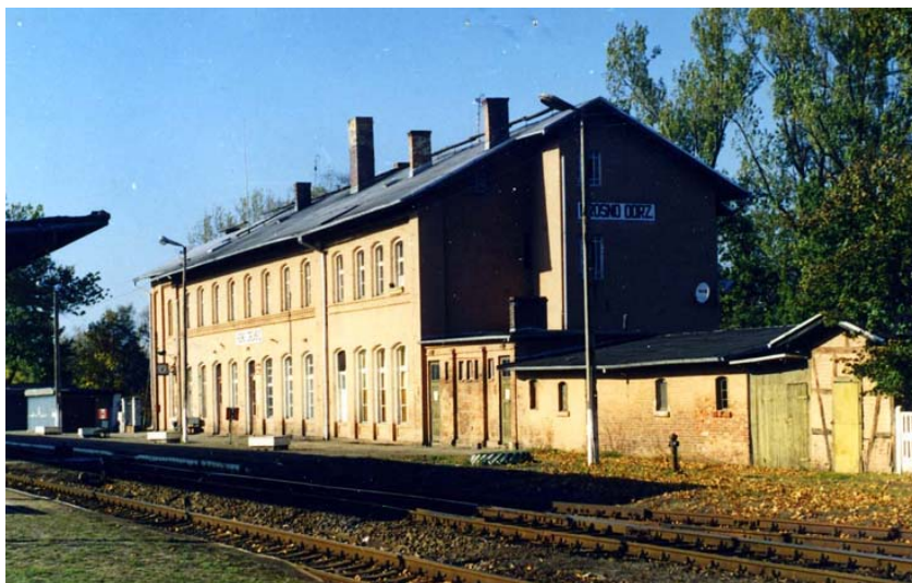
Fot. 4. Budynek stacji kolejowej w Krośnie Odrzańskim.
