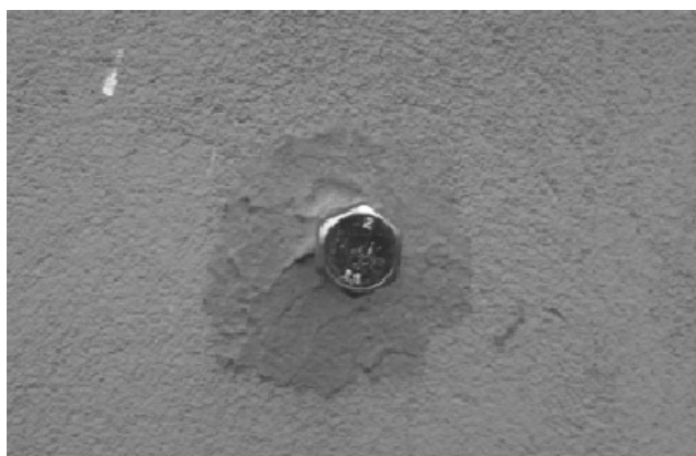
Rysunek 3. Przykład stabilizacji punktu sieci pomiarowo kontrolnej. Źródło: opracowanie własne.
